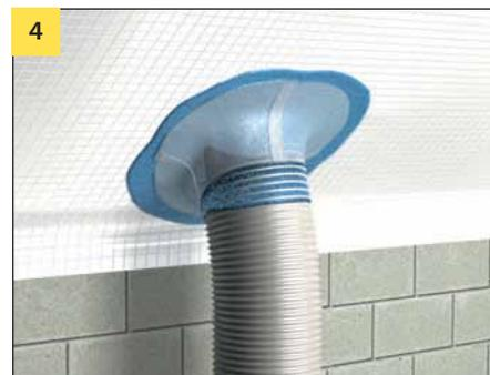
Вентиляционная проходка (Шаг 3 – нанесение второго слоя пасты)
