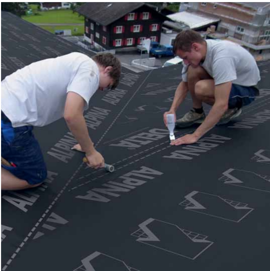
Герметичная проклейка нахлестов DELTA®-ALPINA специальным клеем.
