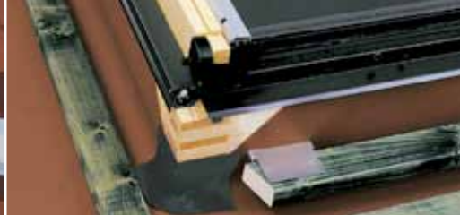
Водонепроницаемость благодаря интегрированным лентам. Уплотнение мансардного окна.
