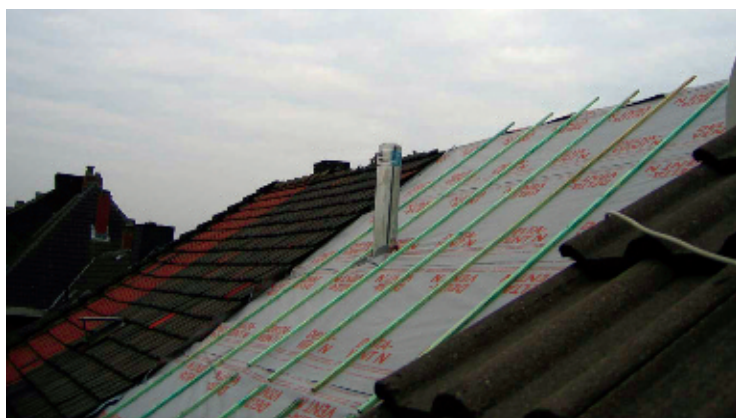
Рис. 5. Диффузионная пленка DELTA@-VENT N в реконструкции мансарды
