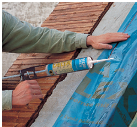
Рис. 10. Возможные повреждения крыши из-за дефектов утепления и ветрозащитной пленки без проклейки нахлестов
