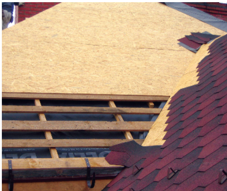
Рис. 11. Монтаж нового кровельного покрытия
