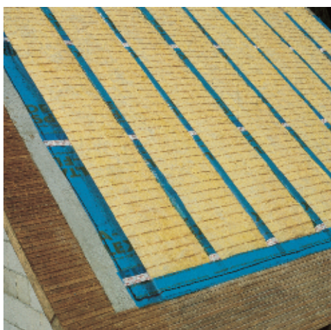
Рис. 9. Монтаж теплоизоляции
