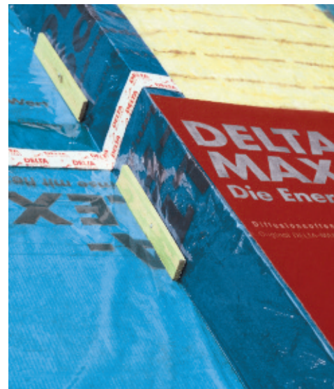
Рис. 6. Капитальный ремонт с помощью пленок DELTA@-Sd-FLEXX и DELTA@-MAXX
