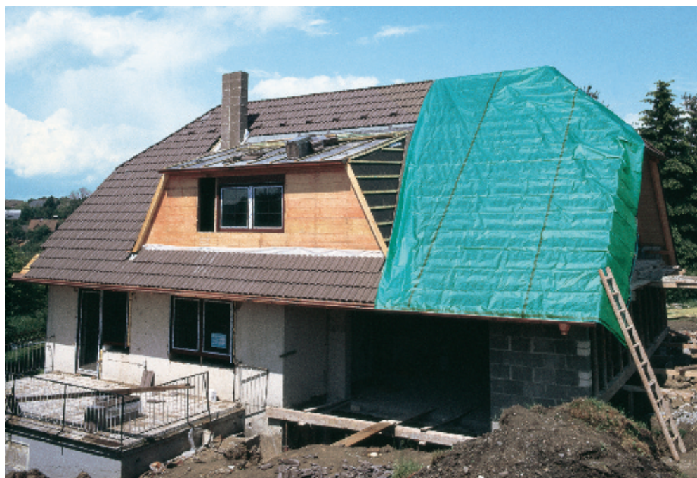
Рис. 3. Защитное покрытие DELTA®-DACHPLANE
