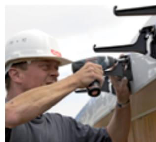
Затем разметить расположение водосточной системы и прикрепить кронштейны к сливной пластине на уровне стропила. Расстояние между кронштейнами должно составлять не более 60 см.
