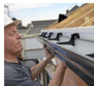
После установки кронштейнов на пластину следует установить желоба.
