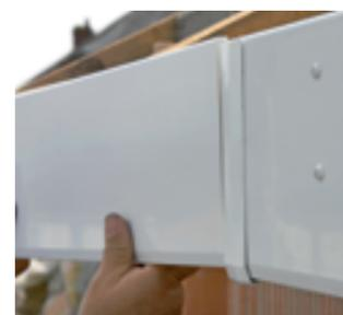
благодаря растробному соединению установить соединительные муфты и уголки между двумя пластинами. Муфты и уголки не приклеивать. С одной стороны задвинуть пластину до упора, а с другой стороны оставить зазор в 5 мм. Для формирования углов следует отрезать пластину под углом 45°.
