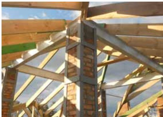
1. Несущие кирпичные столбчатые опоры с установленными двутавровыми балками №30
