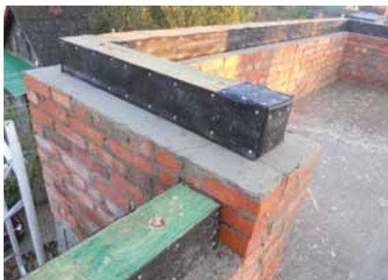
3. Выравнивание основания стены парапета перед монтажом мауэрлата
