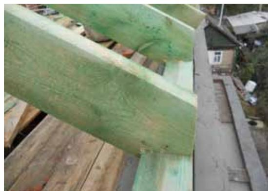
20. Соединение стропильных ног между собой в области двутавра (вид сверху)
