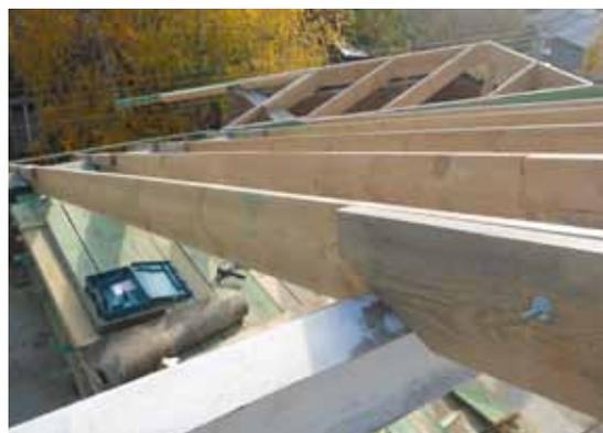
использовались шпильки М12. Удвоенное сечение ног не только обеспечило повышенную несущую способность кровельной конструкции, но и позволило получить длинные неразрезные балки (фото 14).
