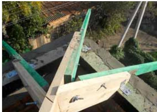
15. Узел соединения кобылки со стропильной ногой при помощи шпильки M12
