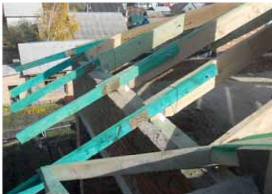
18. Врезка стропильных ног на 1/3 часть с опиранием на металлический прогон (вид сбоку)
