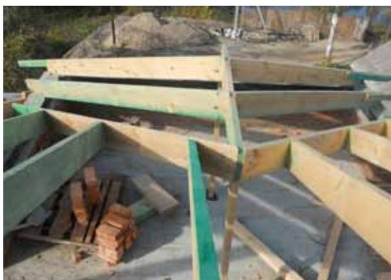
10. Соединение стропильных ног в коньковой части фермы
