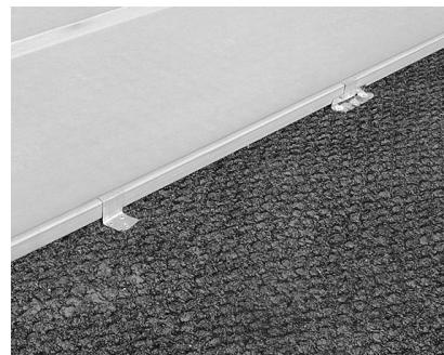
В соответствии с требованиями Немецкого союза кровельщиков (ZVDH „Fachregeln für Metallarbeiten im Dachdeckhandwerk“, март 2006) при монтаже любого металлического покрытия поверх сплошного основания из древесных плит использование объемной диффузионной мембраны является **ОБЯЗАТЕЛЬНЫМ** вне зависимости от угла наклона.
