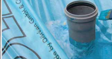
Уплотнение кровельной проходки при реконструкции.
