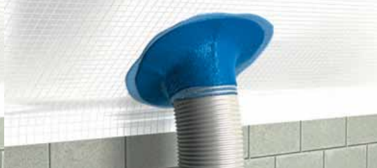
Наносится завершающий слой пасты – примыкание готово!
