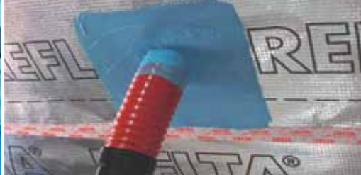
Герметизация вентканала при новом строительстве.
