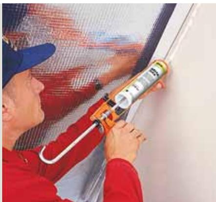
Клей для герметичного и воздухопроницаемого соединения любой пароизоляции со стенами, металлическими и деревянными элементами крыши.
