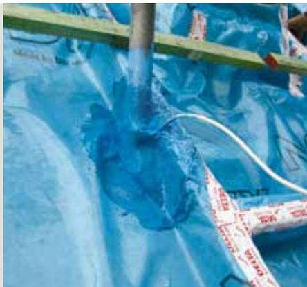
Пастообразное покрытие из акриловой дисперсии с наполнителем из вискозы, применяется для создания воздухопроницаемых примыканий.
