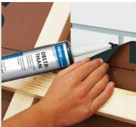
Сохраняющий прочность и эластичность на протяжении длительного времени клей из особого каучука. Только для наружного использования.
