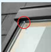
Разделительная рамка между листами стекла выполнена из стали и закруглена по углам. Это предотвращает потерю тепла и образование конденсата по периметру стеклопакета. Коэффициент теплопередачи стали значительно ниже, чем у традиционного алюминия, поэтому стальная рамка лучше защищает стеклопакет от промерзания.
