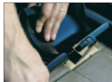
При соединении друг с другом отдельных секций желоба в первую очередь следует закрепить задний край соединительного элемента по краю желоба.
