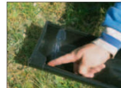
На рисунке показана универсальная торцевая заглушка для водосточного желоба. Металлическая защитная пластина, при необходимости или по Вашему желанию, может быть легко удалена; для этого ее следует вывести из зацепления с предусмотренным пазом. В завершение процедуры установки выровняйте поверхность нанесенного герметика.
