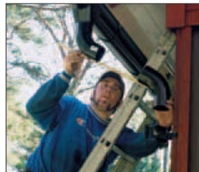
а также применительно к различным размерам выступающих секций. Для использования в качестве промежуточной трубы Вы можете отпилить секцию водосточной трубы адекватной длины.
