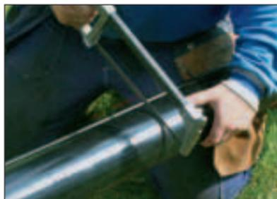
Сделайте два диагональных надреза, используя ножовочное полотно для образования отверстия размером примерно 10 см.
