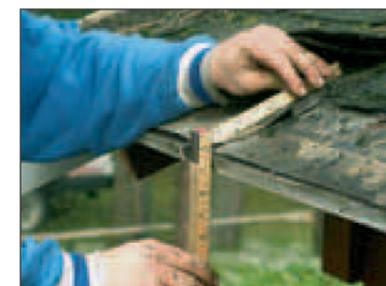
Для того чтобы правильно согнуть первый кронштейн, рассчитайте угол уклона ската кровли. Поместите складной метр параллельно крыше таким образом, чтобы он свободно свисал по вертикали (проверьте вертикаль с помощью спиртового уровня).
