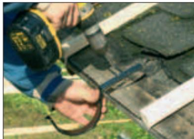
Для фиксированных кронштейнов: согните кронштейн до нужного угла и жестко закрепите кронштейн саморезами на предусмотренном месте установки. Для корректного определения длины кронштейнов обратитесь к инструкции, изложенной выше по тексту раздела. 70-мм и компактные кронштейны следует использовать только для крепления на вертикальных бордюрных рейках; такой тип кронштейна не требует изгибания.
