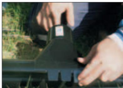
Надавите на воронку и плотно прижмите ее к поверхности желоба; зафиксируйте воронку на месте с помощью ушек, расположенных по задней стороне.
