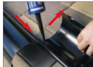
Края отдельных секций желобов могут быть скошены и соединены внахлест. Используя плоскогубцы, отогните металлический край вверх (см. направление, указанное на рисунке стрелками). Далее нанесите вдоль стыка полоску из герметика для металлических поверхностей. Обязательно учитывайте фактор уклона водосточного желоба. Секция желоба, предназначенная к установке непосредственно рядом с водосточной трубой, должна занимать нижнее положение в соединении двух секций.
