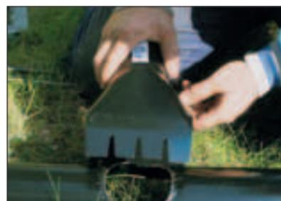
Загните края сделанного в желобе отверстия вниз таким образом, чтобы обеспечить беспрепятственное стекание дождевой или талой воды в воронку, расположенную ниже желоба. Разместите воронку над проделанным отверстием и зафиксируйте ее таким образом, чтобы изогнутая часть секции надежно обхватила вывернутую поверхность водосточного желоба.
