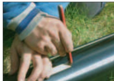
Нанесите отметку на желоб в том месте, где предусматривается установка водосточной трубы.
