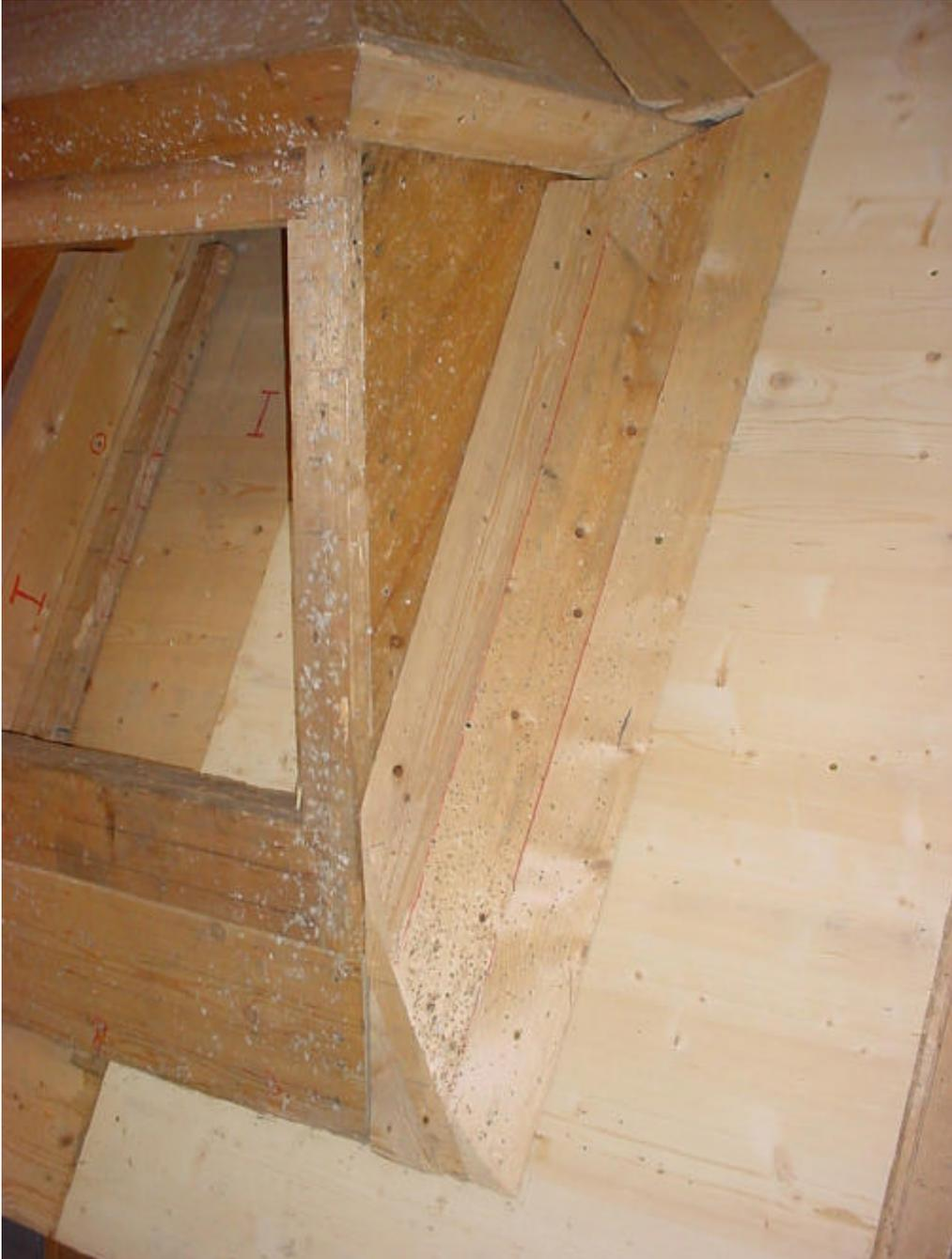
Kehlschiftung unten etwas schmaler, und nach oben hin breiten ca. 3cm
