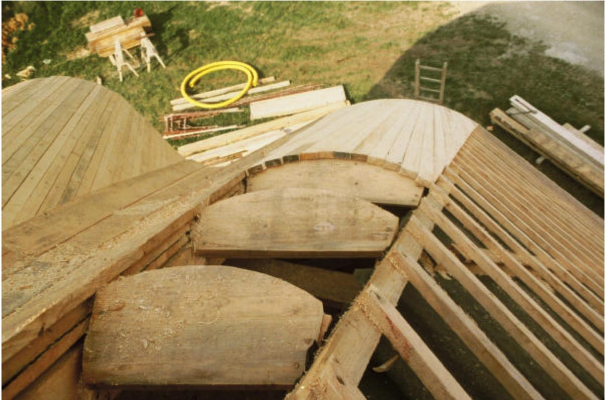
Ausbildung wahlweise mit zwei Gratsparren und Pfostenrahmenden, Schalung (prismiert) teilweise montiert.
