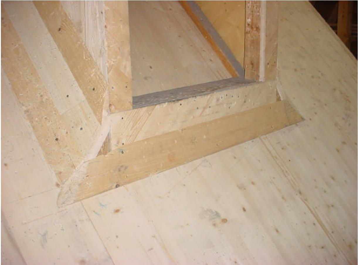
Mit einem Kehlbrett, welches vorne beim Übergang zur Hauptdachfläche abgesetzt ist
