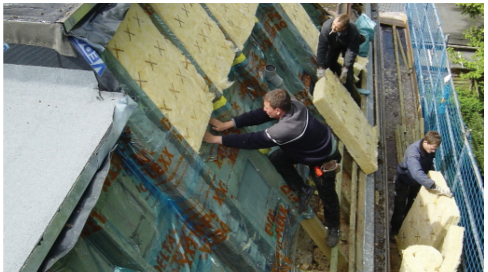
Рис. 18. Санация крыши с применением адаптивной пароизоляции DELTA
