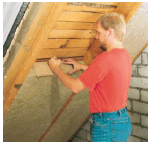
Рис. 6. Профессиональный монтаж плит теплоизоляции
