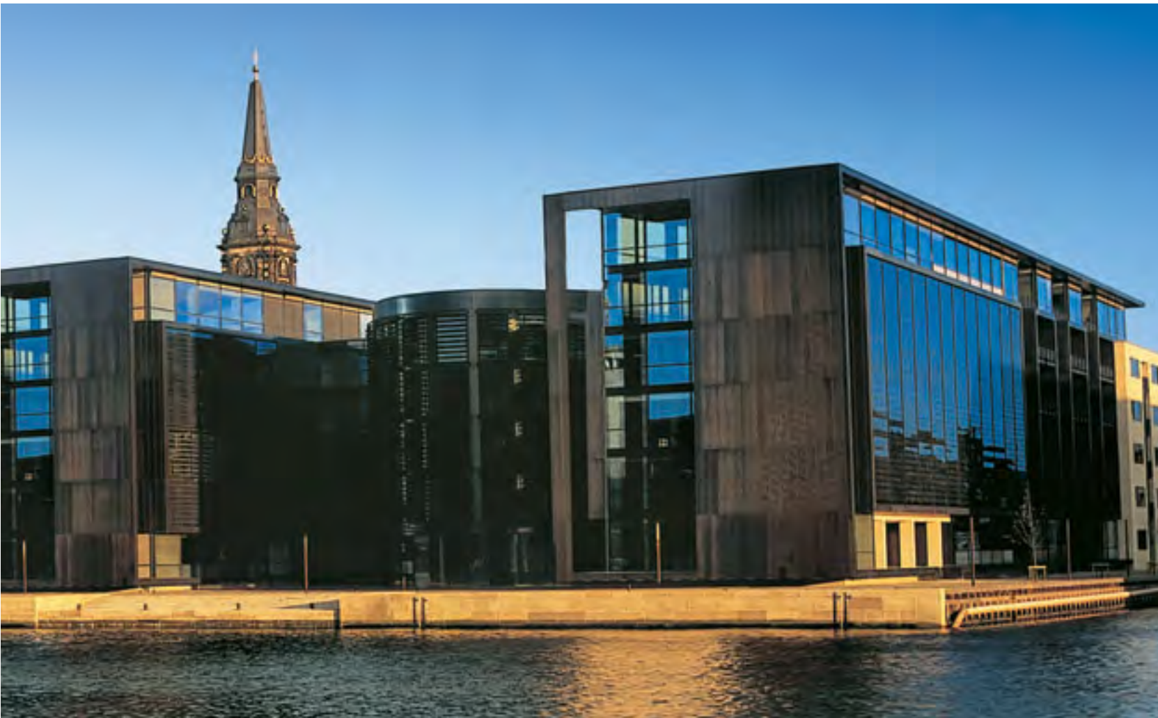
Банк, Копенгаген, Дания Фасады, облицованные медью по методу Nordic Brown TM
