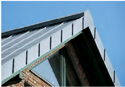
Вентилируемый конек двускатной крыши, высокое исполнение
