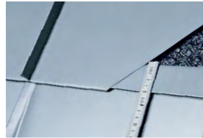
Поперечный шов, как простой фальц
