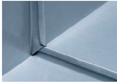
Фальц конвертом у проема кровли (2) фронтальная часть
