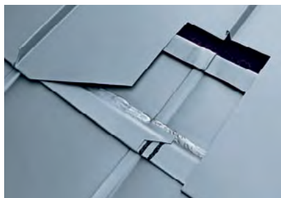
Оптимизация узла: дополнительная планка
