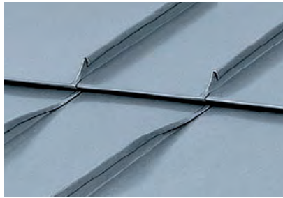
Поперечный шов – простой фальц с дополнительной планкой
