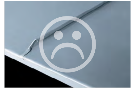
Конек односкатной выполнен как карниз
