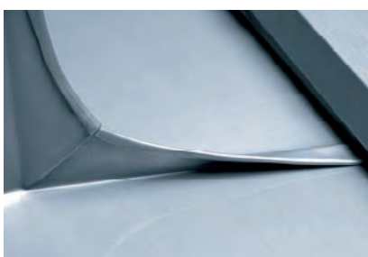
Закругленное продольное соединение(1б) Высота примыкания ≥ 150 мм
