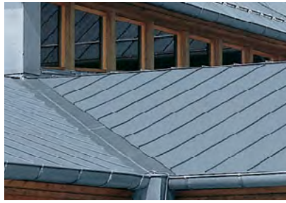
Ендова с простым и дополнительным фальцем
