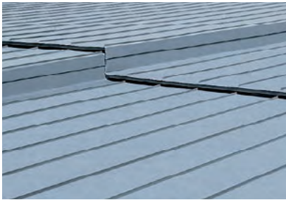
Поперечный шов в качестве перепада
