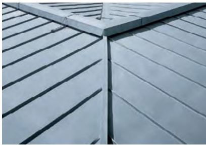
Гребень с брусом и профилем покрытия
