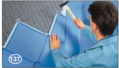
Вариант устройства ендовы
