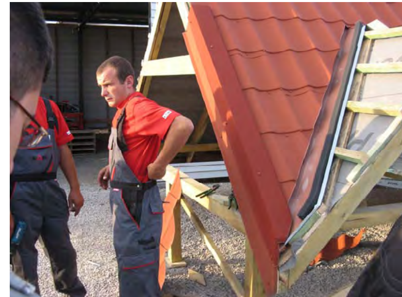
Рис.48. Крепление планки ветрозащиты к ветровой доске
