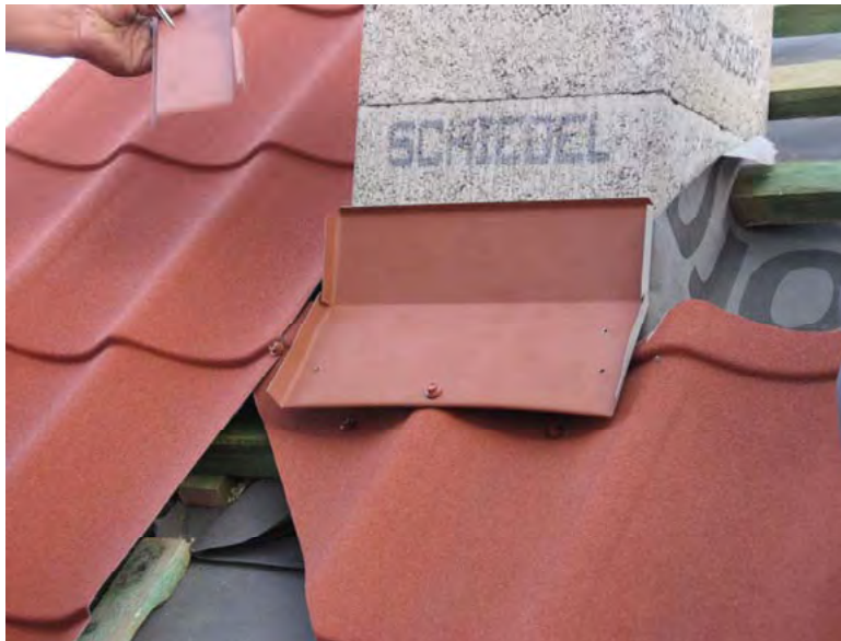
Рис. 65. Монтаж нижней планки фартука
