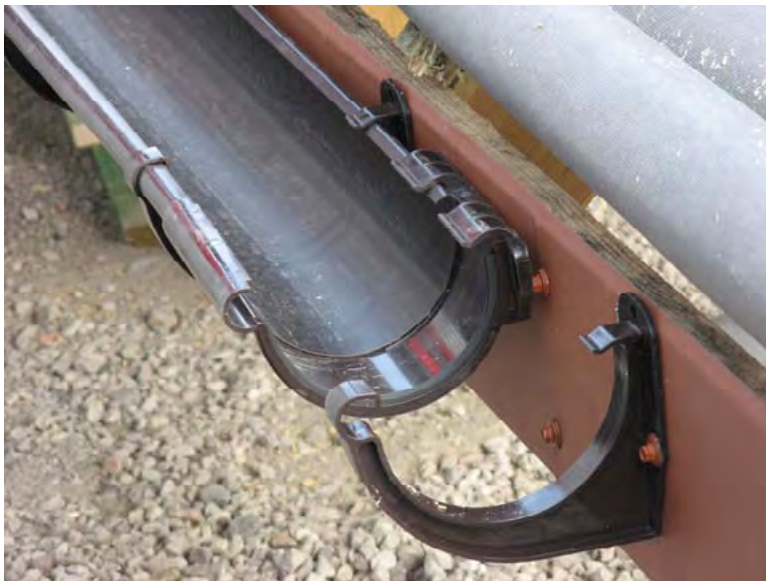
Рис. 52. Установка желобов в кронштейны
