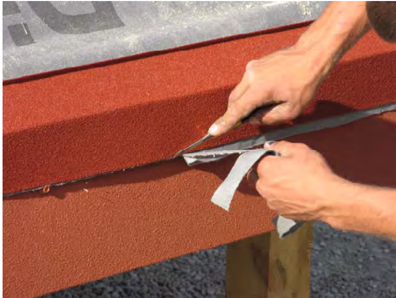
Рис.22. Подрезание краев супердиффузионной мембраны
