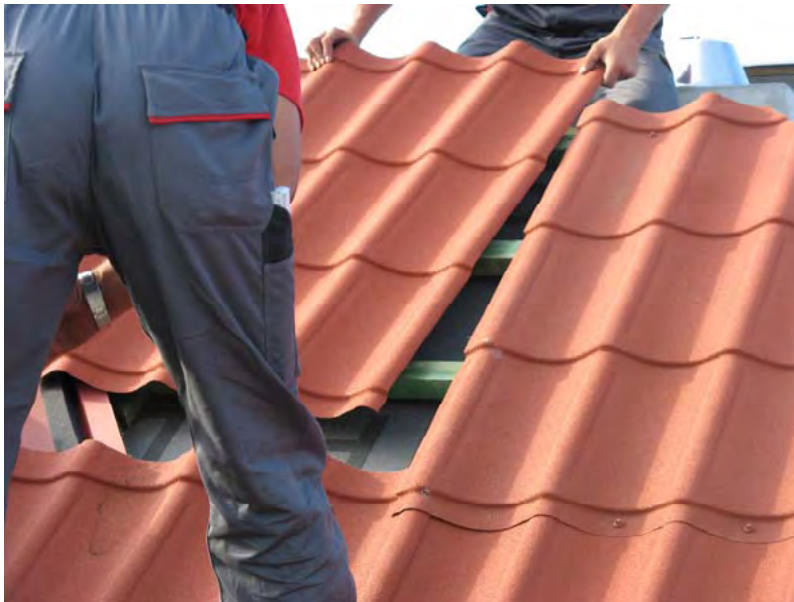
Рис.33. Укладка листа металлочерепицы в проектное положение
