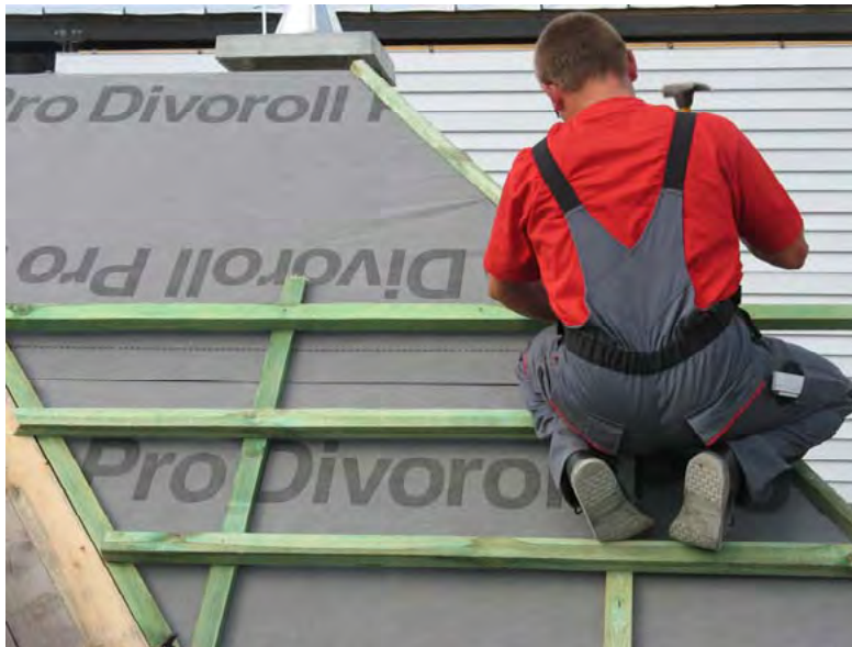
Рис.14. Расположение реек обрешетки на поверхностях скатов
