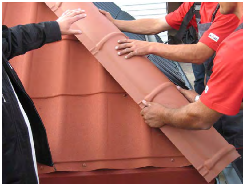
Рис.43. Монтаж планки конька
