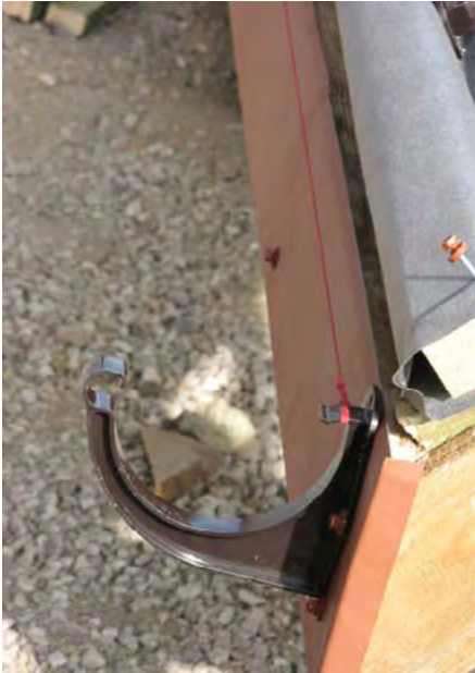
Рис. 51. Установка промежуточных кронштейнов
