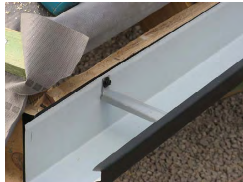
Рис. 58. Крепление планки желоба распорками
