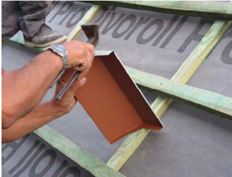
Рис. 64. Изготовление нижней планки фартука
