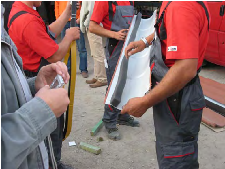
Рис.42. Наклейка универсального уплотнителя
