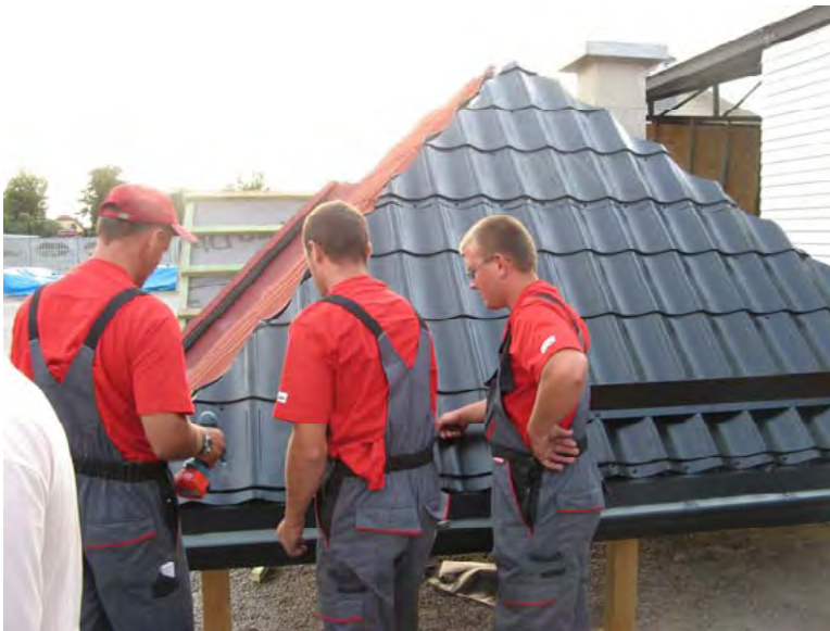
Рис. 62. Расположение планки снегоуловителя вдоль линии карниза ската
