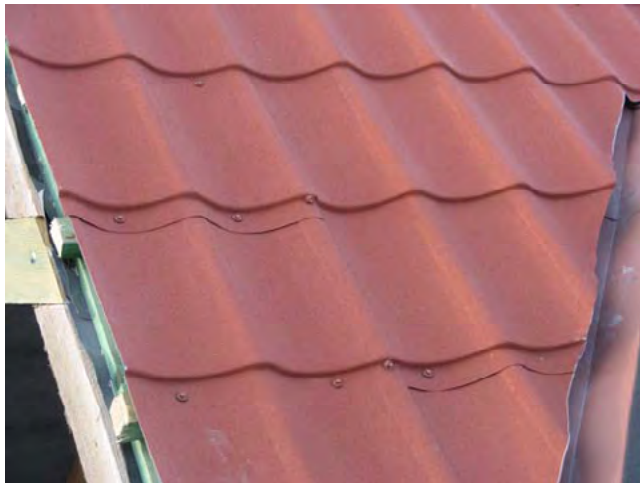
Рис.39. Обрезанные листы металлочерепицы на ендове
