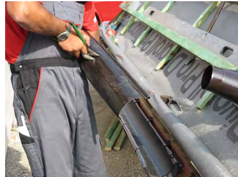
Рис. 54. Вырезание отверстия в желобе для водостока
