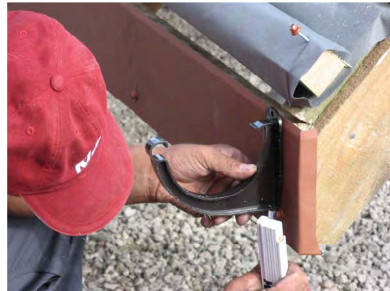
Рис. 50. Установка маяковых (крайних) кронштейнов
