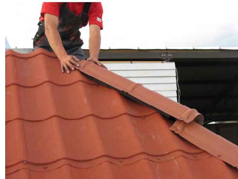
Рис.45. Монтаж смежных планок по длине конька
