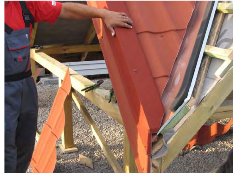
Рис.47. Монтаж планки ветрозащиты
