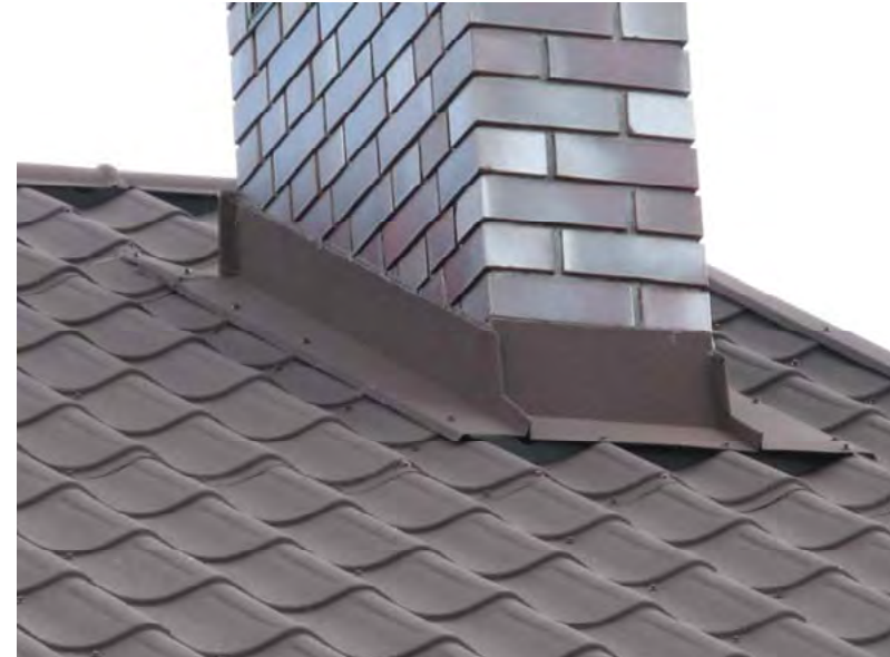
Рис. 72. Вид слева на дымоход с планками фартука
