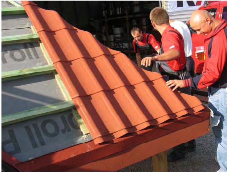
Рис.29. Окончательное закрепление первого листа металлочерепицы
