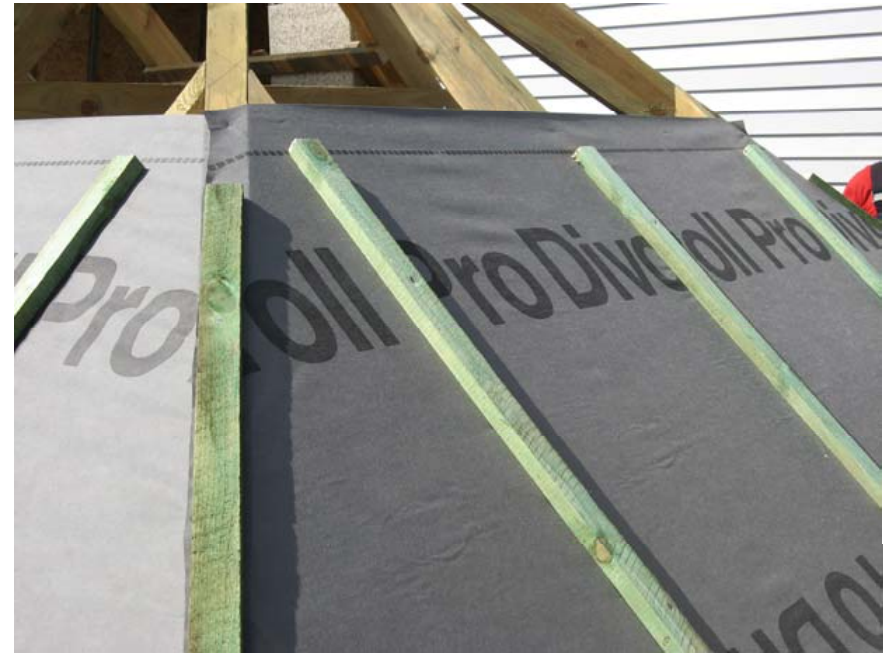
Рис. 11. Устройство контрреек
