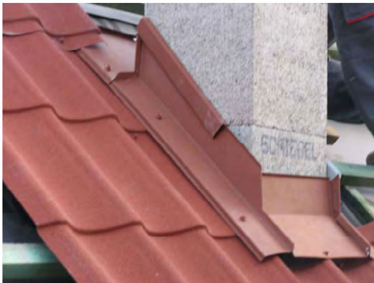
Рис. 71. Устройство защитно-декоративной полосы
