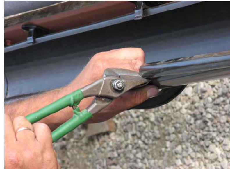
Рис. 53. Подрезание желобов
