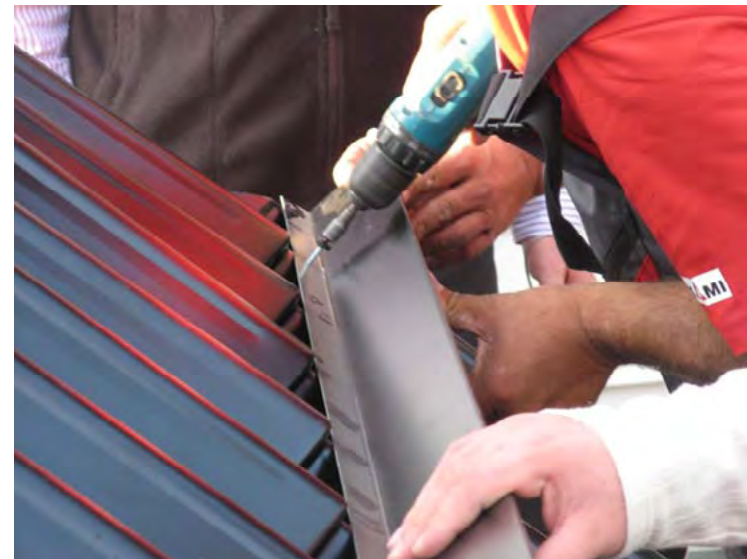
Рис. 61. Крепление планки снегоуловителя к обрешетке
