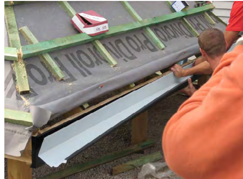
Рис. 57. Размещение планки желоба на лобовой доске
