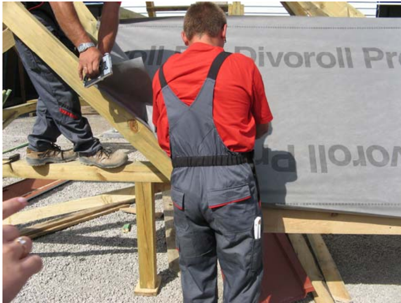
Рис. 9. Раскладка полотнищ мембраны на поверхности ската
