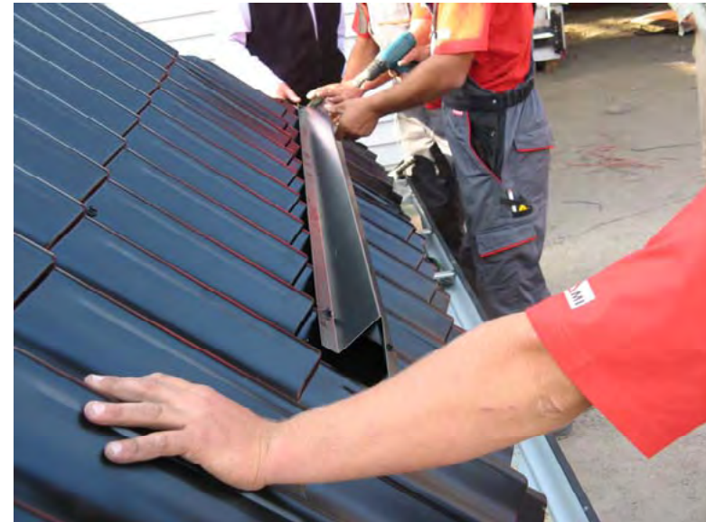
Рис. 60. Расположение планки снегоуловителя на скате
