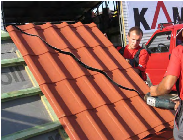
Рис.26. Подрезание первого листа металлочерепицы
