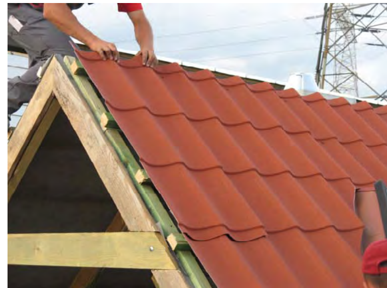
Рис.38. Окончательное крепление последнего листа на скате
