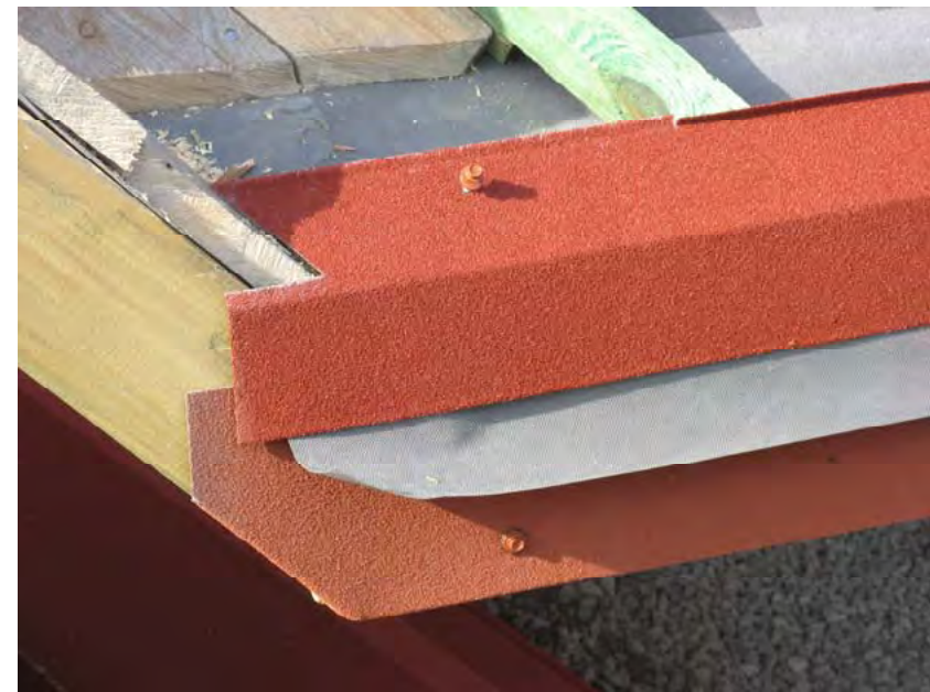
Рис.21. Размещение карнизной планки
