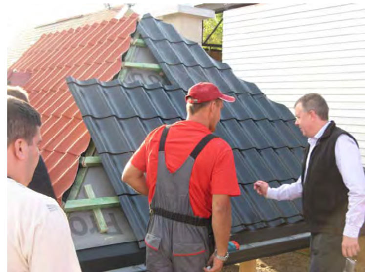
Рис.41. Расположение листов металлочерепицы на смежных скатах
