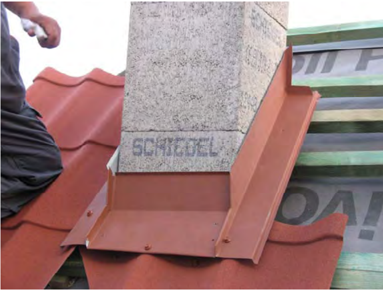
Рис. 67. Монтаж боковых планок фартука
