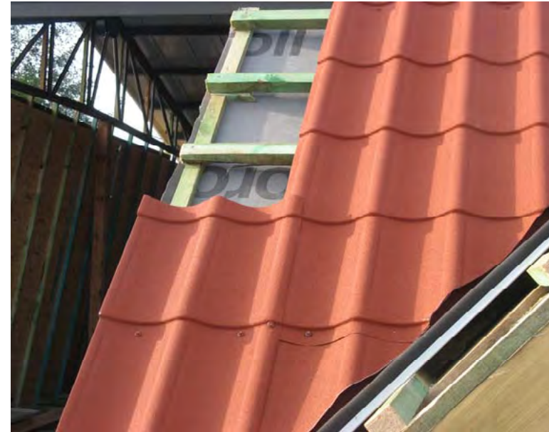
Рис.37. Проектное расположение последнего листа на скате
