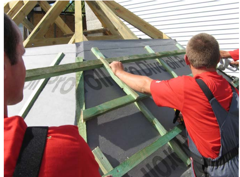
Рис.12. Монтаж рядовых реек обрешетки
