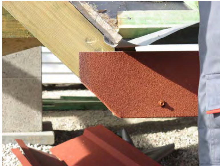
Рис.20. Размещение планки зашивки лобовой доски карниза
