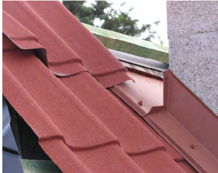
Рис. 70. Напуск металлочерепицы на верхнюю планку фартука
