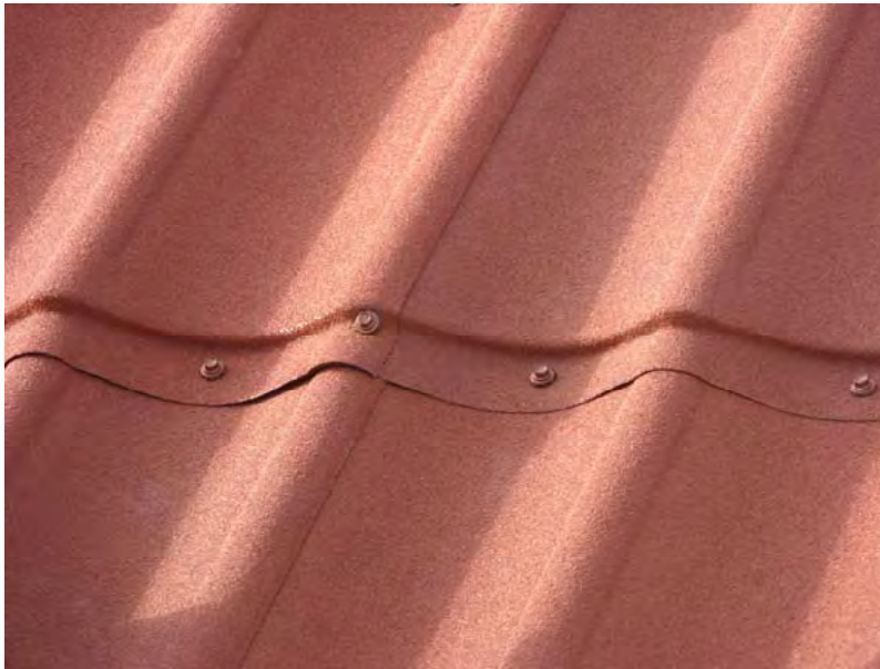
Рис.36. Окончательное крепление
