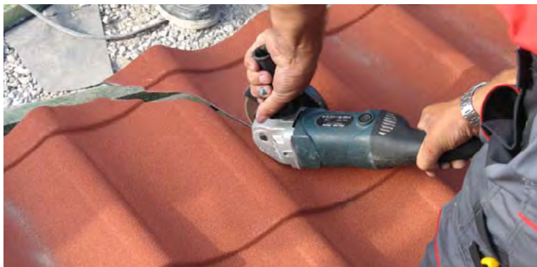
Рис.30. Подрезка второго листа металлочерепицы
