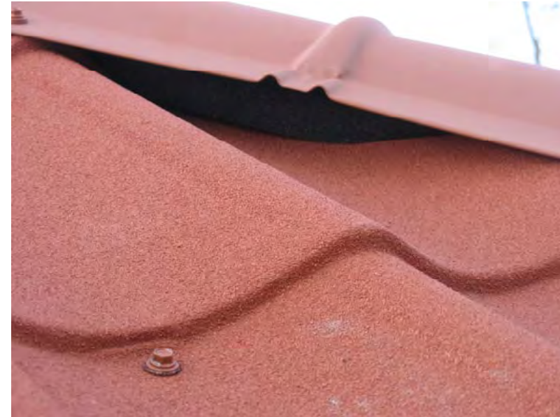
Рис.44. Герметизация подкровельного пространства возле конька
