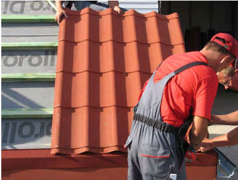
Рис.25. Монтаж первого листа металлочерепицы
