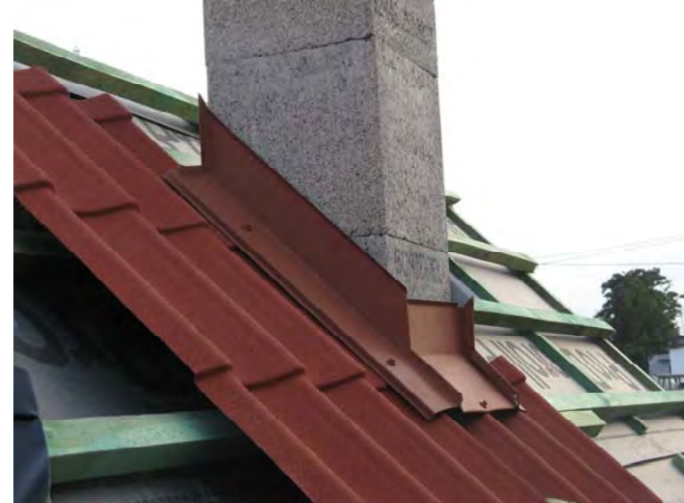
Рис. 68. Расположение боковых и нижней планок фартука
