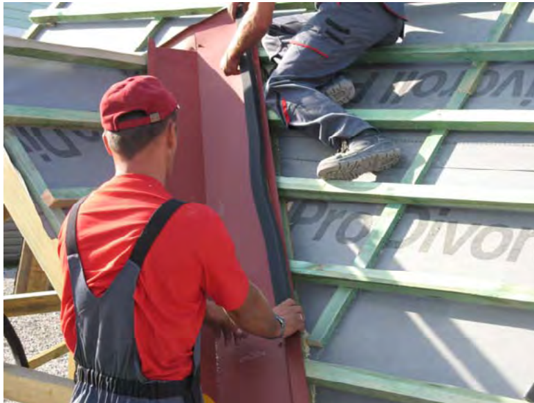
Рис.16. Устройство планки на ендове
