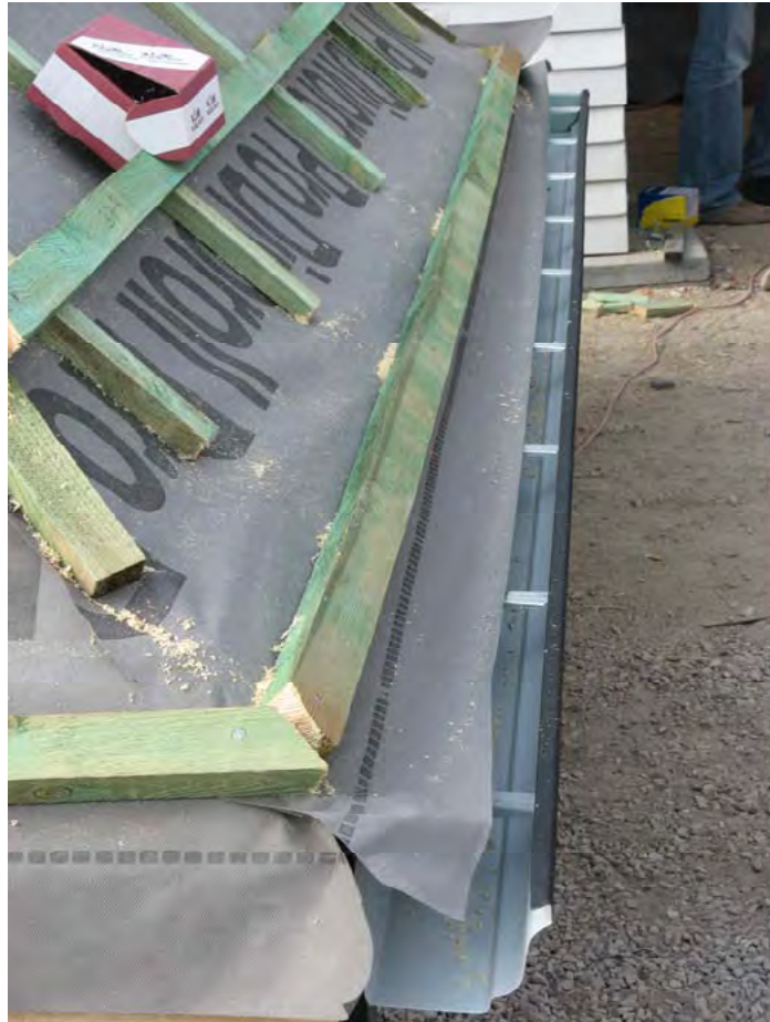
Рис. 59. Выпуск супердиффузионной мембраны в желоб
