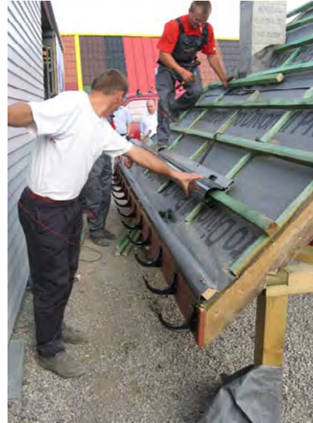
Рис. 51. Установка промежуточных кронштейнов
