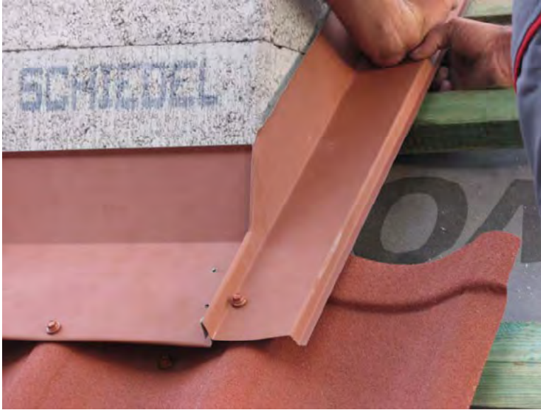
Рис. 66. Определение размеров боковой планки фартука
