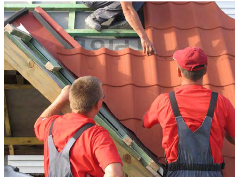
Рис.32. Монтаж третьего листа металлочерепицы
