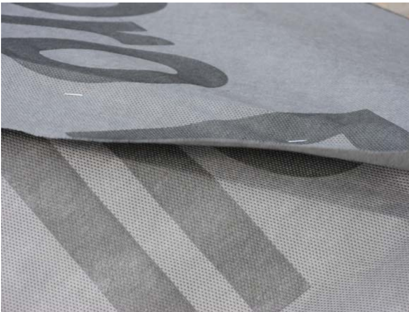
Рис. 10. Соединение смежных полотнищ мембраны на стропилах
