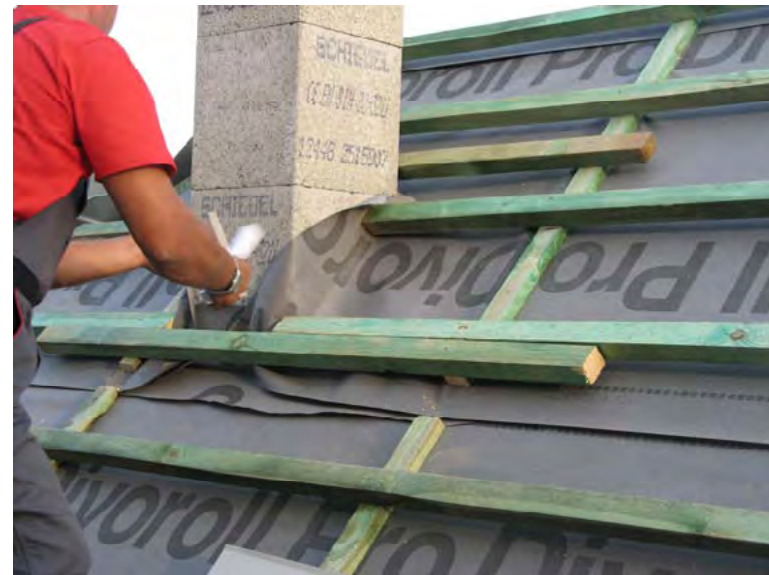
Рис. 63. Общий вид дымохода
