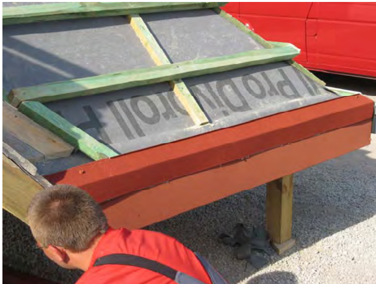
Рис.23. Расположение карнизной планки по длине карниза
