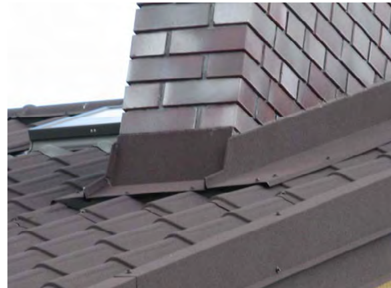
Рис. 73. Вид справа на дымоход с планками фартука
