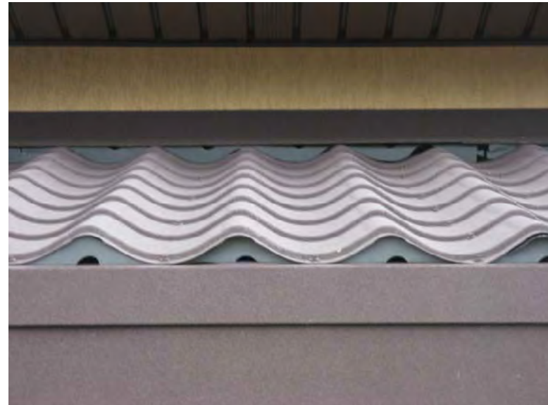
Рис. 74. Расположение уплотнителя на коньке и карнизе ската
