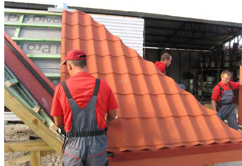
Рис.31. Монтаж второго листа металлочерепицы
