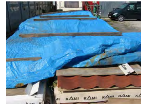
Рис.7. Хранение листов металлочерепицы на открытом воздухе
