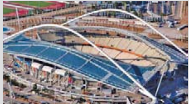
Олимпийский стадион, Афины (кровля). Применялся 12 мм лист монолитного поликарбоната.
