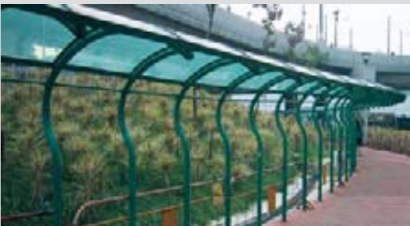
Навес над остановкой жд транспорта в Гонконге. Применялся 6 мм зеленый лист монолитного поликарбоната.
