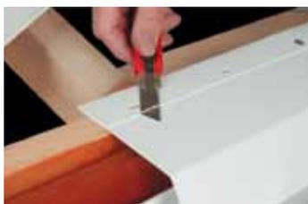
С помощью ножа сделать прорез 10 см сквозь антикапиллярное рифление. Наложить две секции без склеивания, учитывая преобладающий ветер. Совместить 2 овальных отверстия и скрепить профили гвоздями.
