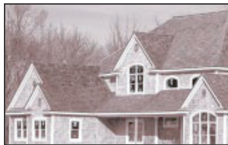
Крыша с деревянной обшивкой
