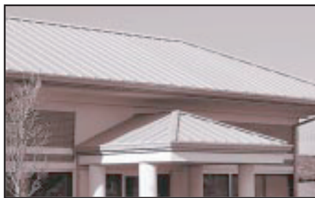
Металлическая крыша
