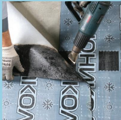
▲ Формируя торцевой (поперечный) нахлест, необходимо снять звукоизоляционный слой 150 мм. Все нахлесты сплавляются горячим воздухом при помощи строительного фена.
