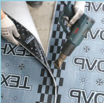
▲ Техноэласт АКУСТИК-СУПЕР - материал не только звукоизоляционный, но и гидроизоляционный. Для формирования сплошного водонепроницаемого ковра в материале Техноэласт АКУСТИК-СУПЕР предусмотрен продольный нахлест 100 мм.
