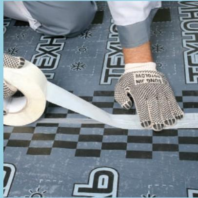
▲ Техноэласт АКУСТИК укладывается в стык, без формирования нахлеста. Два соседних полотна склеиваются липкой лентой.
