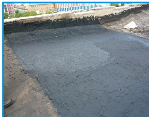
ВИР-пласт до прикатки, еще горячий
