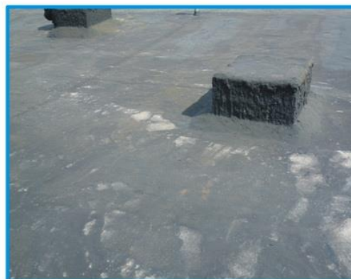
ВИР-пласт до прикатки, еще горячий
