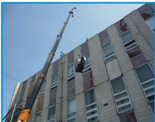
Подъем оборудования на кровлю
