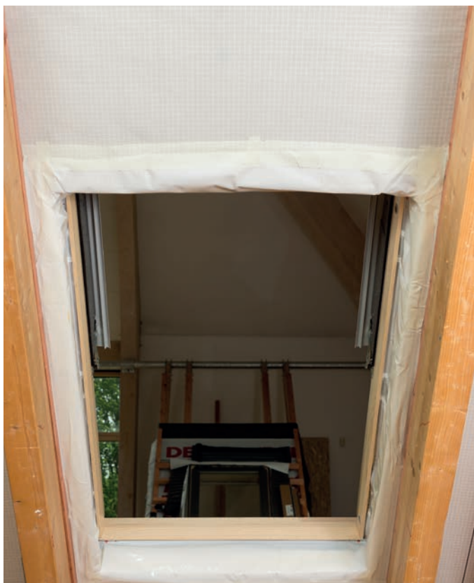
Do drážky pod sádkarton osadíme manžetu BBX a perfektně propojíme s parozábranou střešní konstrukce.
