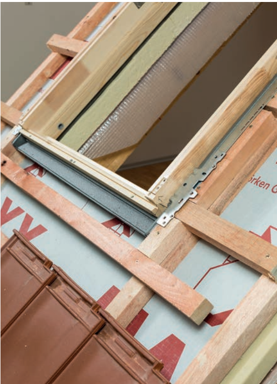
Do osazené zateplovací sady vložíme okenní rám.
