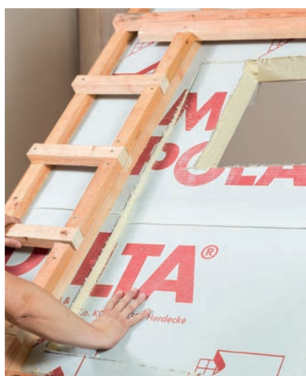
Vyřezání tepelné izolace a parozábrany po vnitřní hraně označené zateplovací sady.
