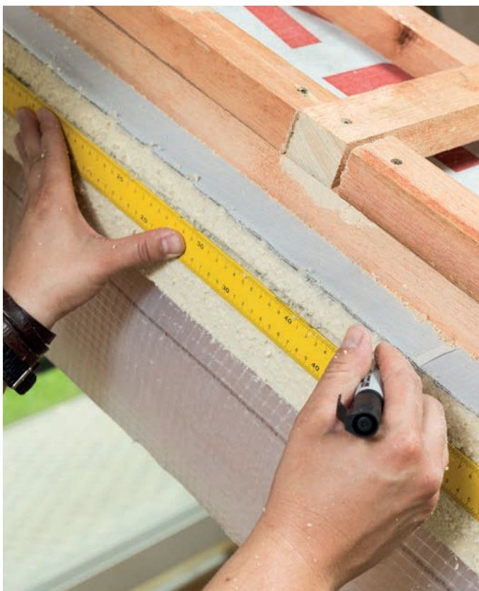
Vytvoření ozubu pro osazení zateplovací sady.
