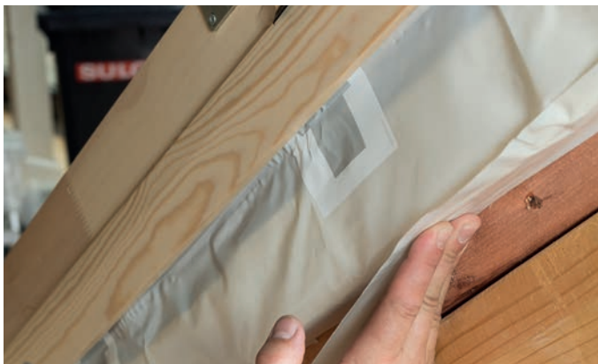
Do drážky pod sádkarton osadíme manžetu BBX a perfektně propojíme s parozábranou střešní konstrukce.
