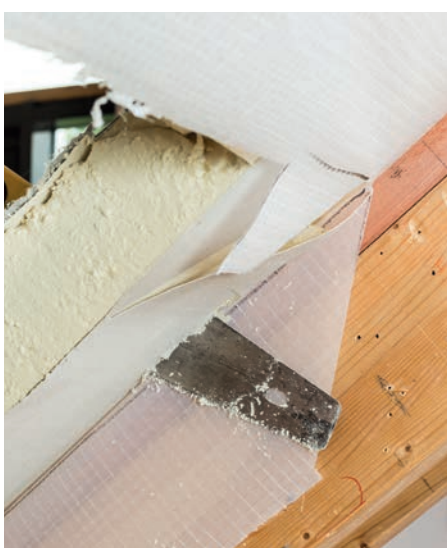
Vyřezání tepelné izolace a parozábrany po vnitřní hraně označené zateplovací sady.
