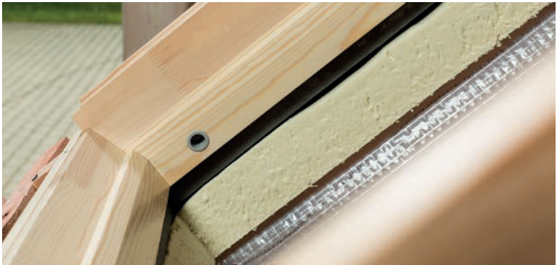
Do osazené zateplovací sady vložíme okenní rám.
