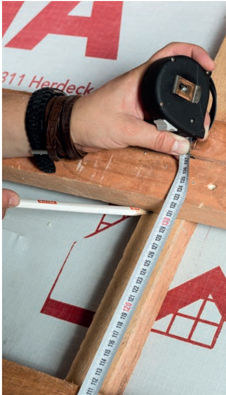
Příprava montážního otvoru v laťování dle montážního návodu.
