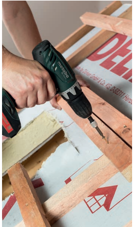
Příprava montážního otvoru v laťování dle montážního návodu.
