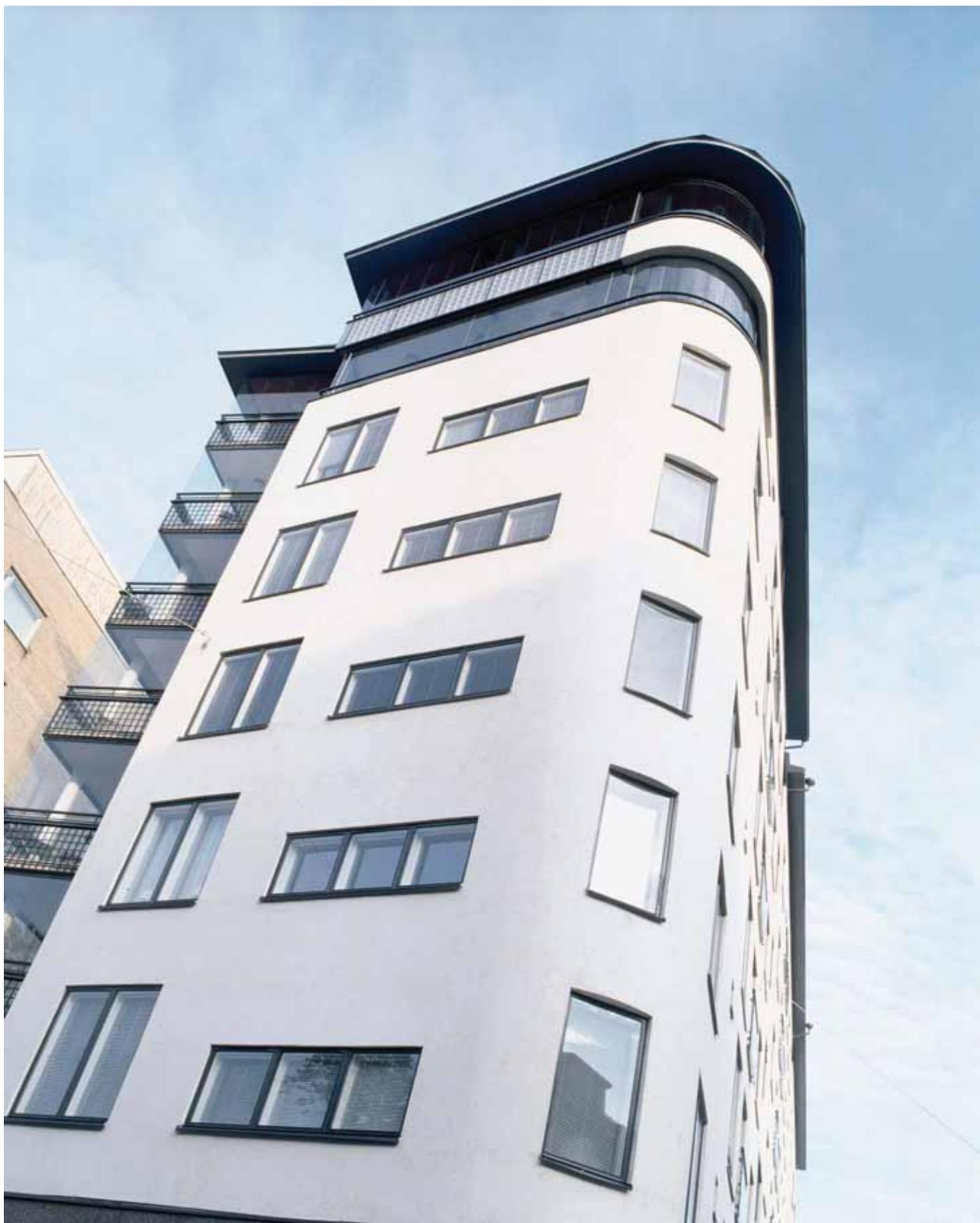
Благодаря поперечной гибкости ламелей, отделку можно применять на кривых поверхностях.
