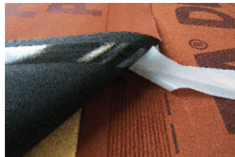
Рис. 5. Водонепроницаемое соединение нахлестов диффузионной мембраны, имеющей встроенные самоклеящиеся ленты.
