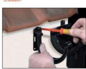
Place the necessary support brackets with a distance of + 33cm. Закрепите необходимое количество кронштейнов на расстоянии ± 33 см.
