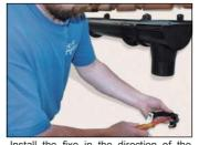
Install the fixo in the direction of the Attach the pipe to the outlet. drainpipes. Закрепите хомут прямо по направле- Установите трубу. нию стока воды.
