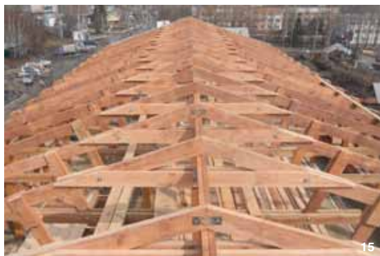
14. Общий вид фермы: ригель, подкосы, затяжки и коньковый прогон
