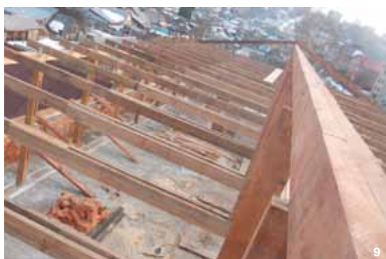
8. Общий вид вертикальных составных стоек 2×(150×40) мм
