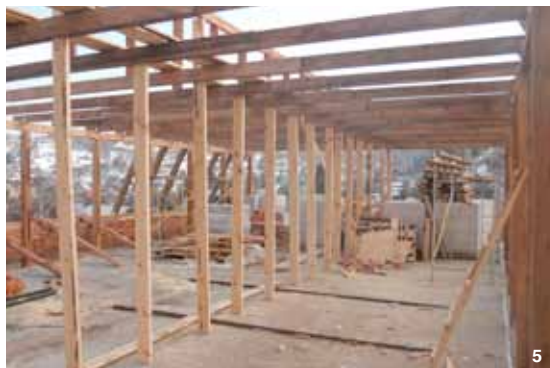
4. Монтаж ригелей из составных 2(150×40) мм и одинарных элементов 150×40 мм
