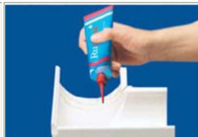
8.2. После того, как уголок приклеен, желоб устанавливается в кронштейнах. После этого наносится клей на вторую половину уголка, и с ним соединяется следующий желоб.
