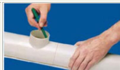
6.2. Далее производятся два косых запила с помощью ножовки с мелкозубчатым полотном. Запилы должны располагаться друг напротив друга. Края распилов зачищаются.
