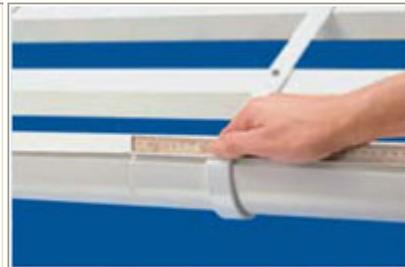
7.2. Выполняя соединение желоба, необходимо уделить внимание тому, чтобы концы были плотно состыкованы. На внутреннюю поверхность соединительного элемента наносится клей в виде 4 полос шириной около 5 мм. Клей наносится на расстоянии около 15 мм от края.
